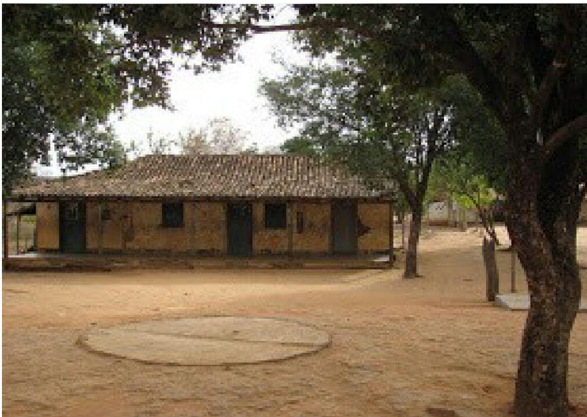
Fotografia 8 - antiga casa aonde era a sede do fazendeiro Zé Tinhô, onde primeiro funcionou a escola, 2017 Fonte, Aparecido Rodrigues
