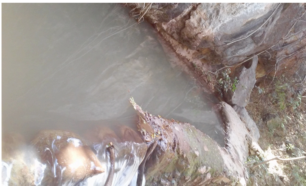
Foto 4 - A armação do açude vista por cima. Aldeia Barra do Sumaré, Terra Indígena Xakriabá. Julho de 2015.
