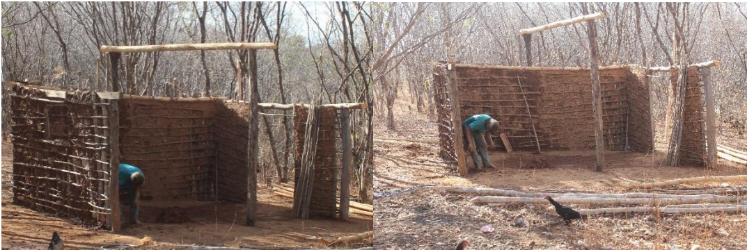
Figura25: Inchimento da segunda e da terceira parede
