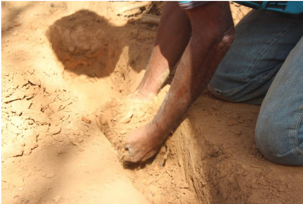
Figura 16: Abertura das valetas de 2 a 3 palmos
