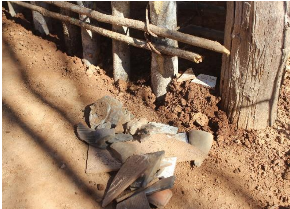
Figura 22: Início do inchimento com pedaços de pedras, cerâmicas e cacos de telhas
