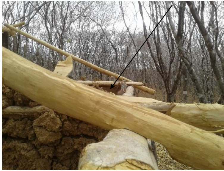
Figura 34: Madeiramento da casa, caibros
