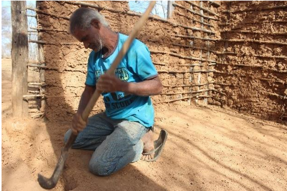
Figura 26: Abertura de uma vala para a frente da casa – 4ª parede
