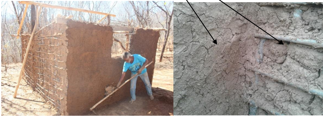
Figuras 32: Parede com o sem rebolque
