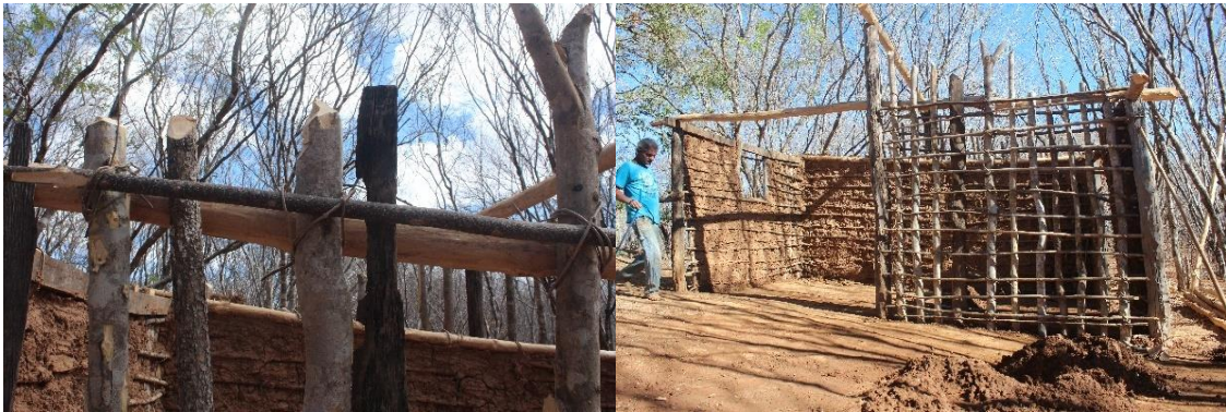
Figura 27: Estrutura da 4ª parede de pau-a-pique
