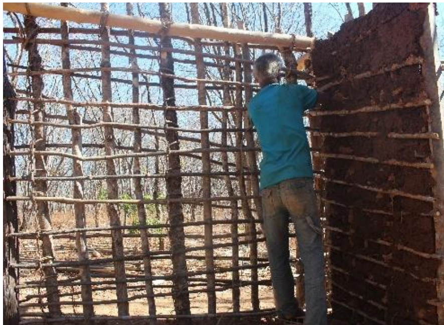
Figura 24: Primeira parede pronta
