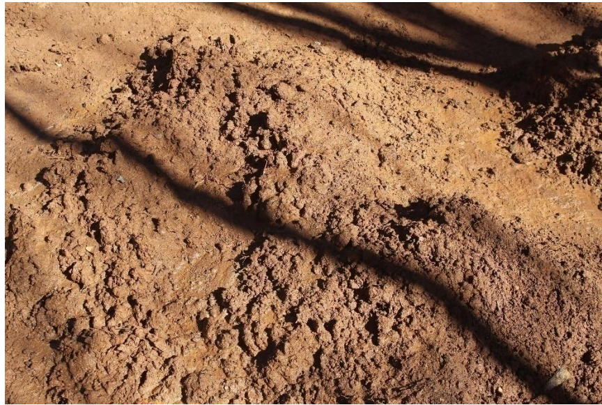
Figura 30: Preparo para fazer o rebolque
