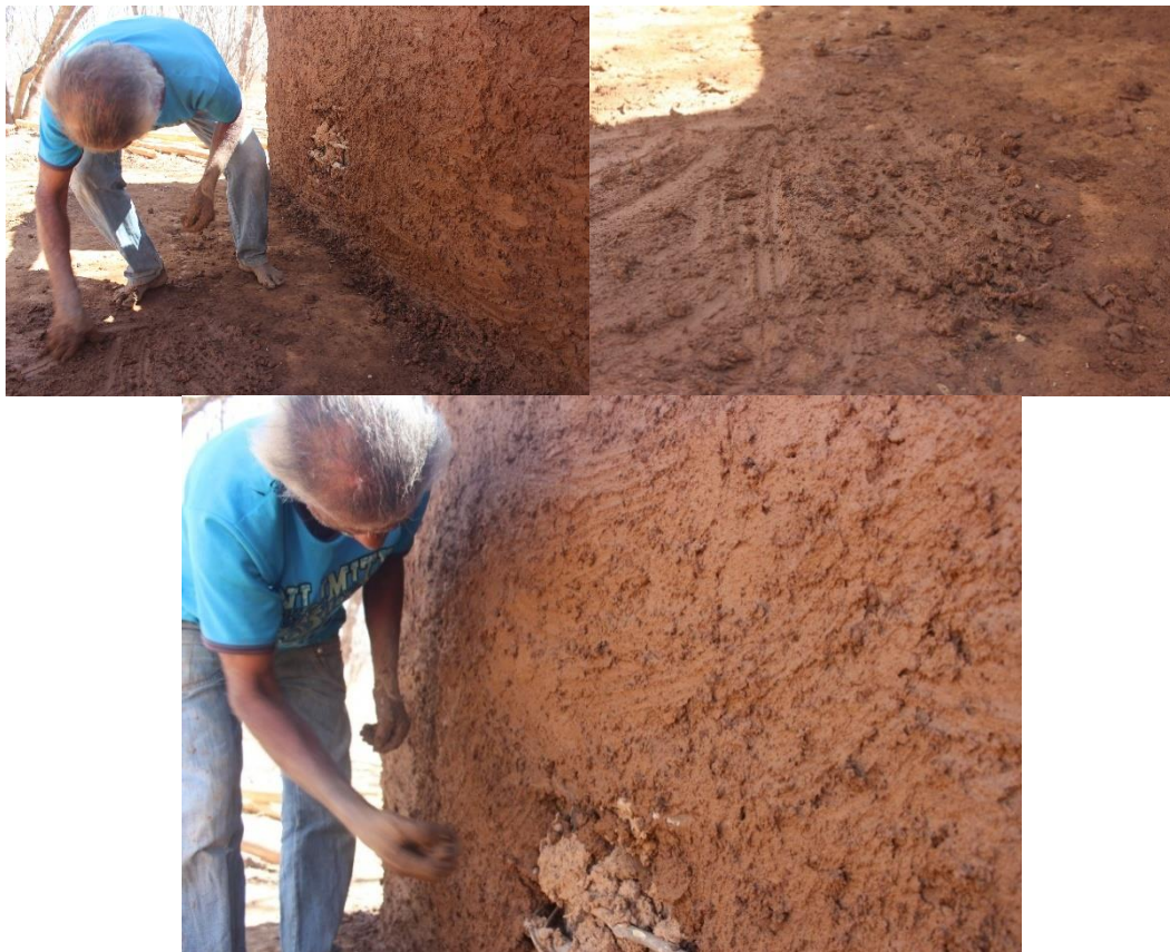
Figura31: Aplicação do rebolque
