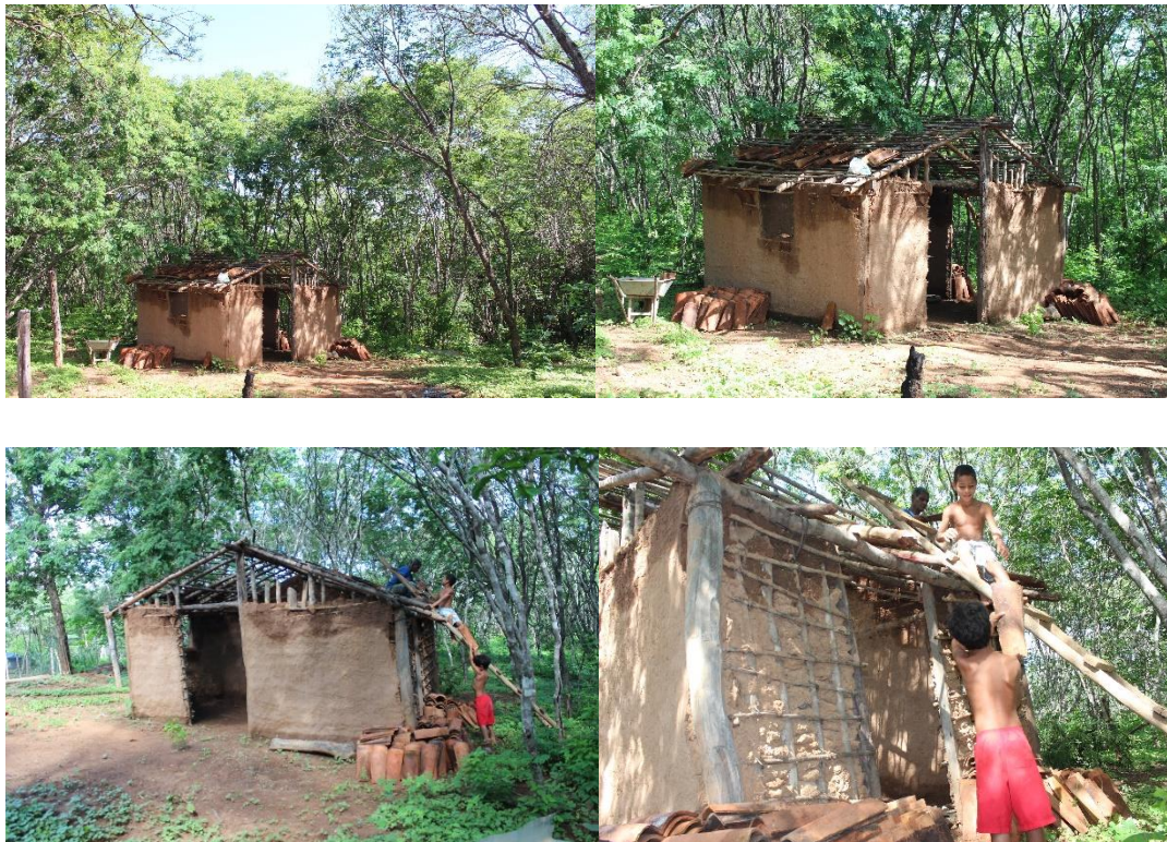
Figura 38: Construção das Coberturas da casa
