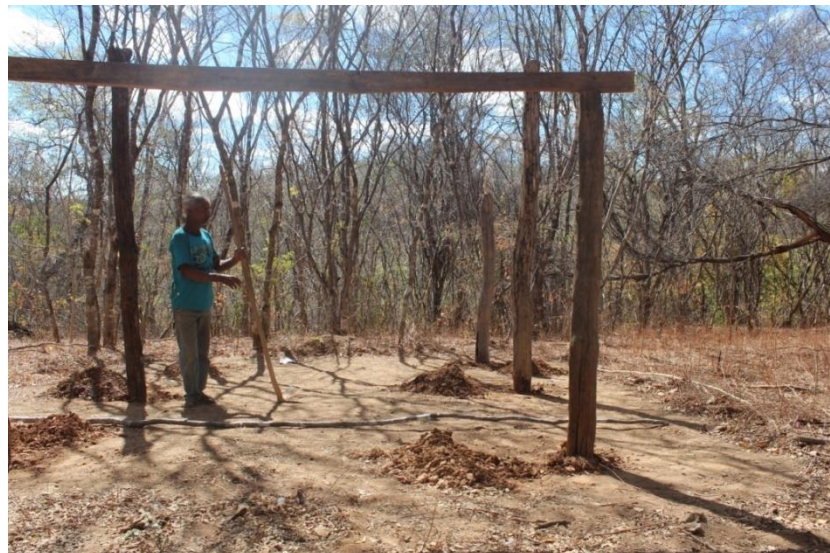
Figura 14: Levantamento dos Esteios
