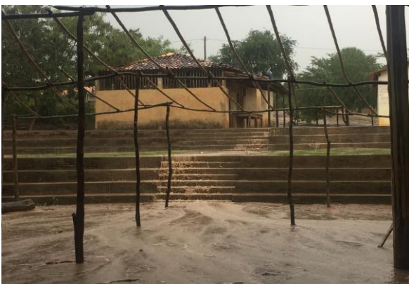
Imagem 47: invasão da enxurrada na arquibancada e pátio central. – Fonte: Próprios autores.
