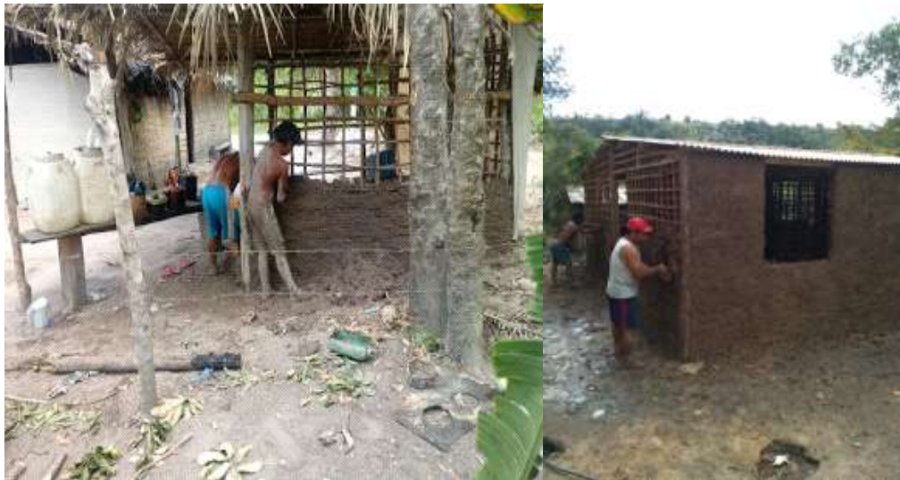
Imagens 27 e 28 - Construção da casa tradicional na Aldeia Boca da Mata e Aldeia Córrego da Cassiana. Fotografia de Wallas Ferreira, 2019.
