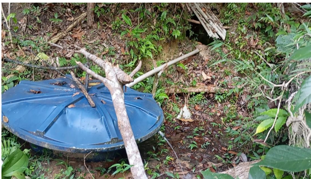
Figura 29: Caixa de água que armazena a água que vem da nascente pelo cano, arquivo Andréia Braz, 2024.
