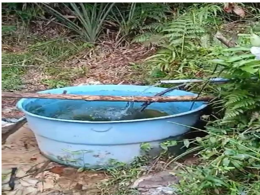
Figura 43: Caixa de água armazenando a água que vem da nascente pelo cano, arquivo Andréia Braz, 2024.
